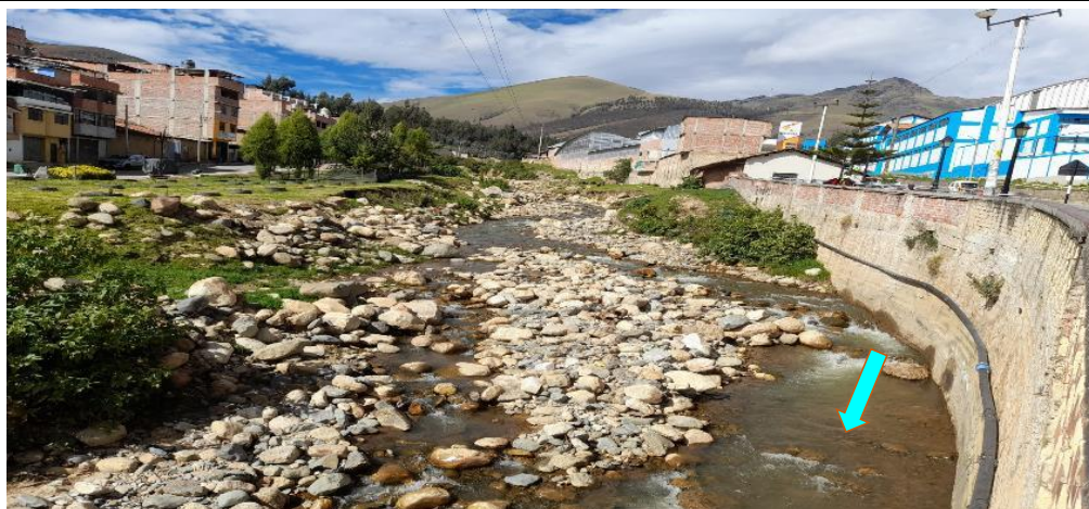
FIGURA N°01: TRAMO CRÍTICO EN EL RIO GRANDE EN EL SECTOR CANDOPATA SE APRECIA AGUAS ABAJO LA NECESIDAD DE ENROCADO EN LA MARGEN DERECHA
