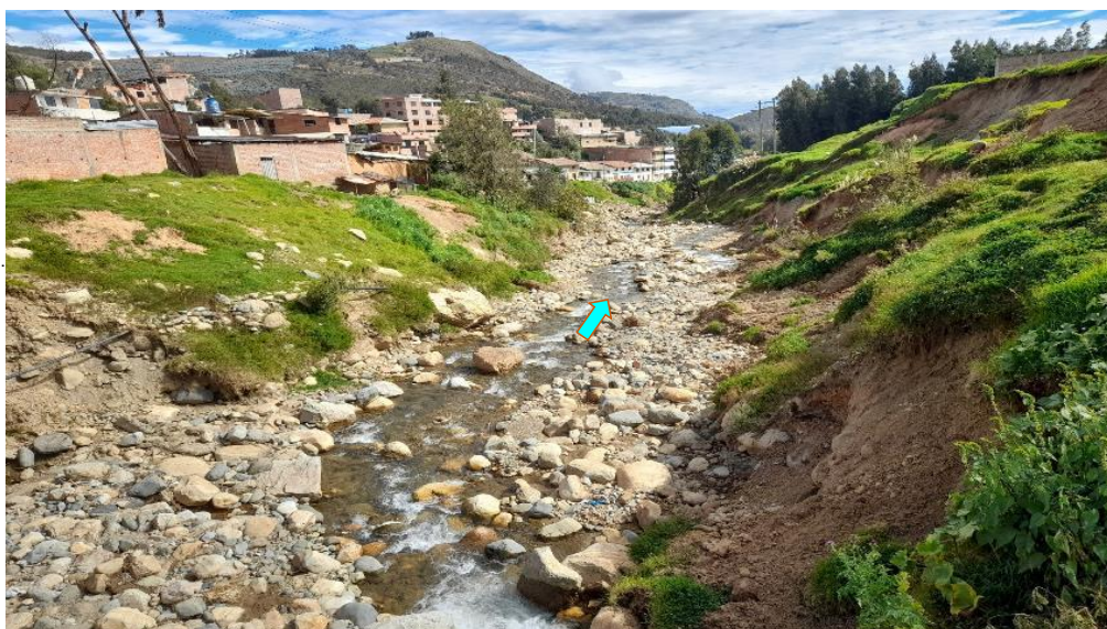
FIGURA N°03: SE OBSERVA QUE EN AMBAS MARGENES DEL TRAMO DEL SECTOR CANDOPATA DEL RIO GRANDE EN EPOCA DE AVENIDAS EROSIONA LOS TALUDES NECESITANDO DE UNA PROTECCION PERMANENTE
